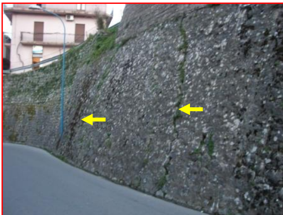
Centro abitato – Dissesto 016I-5GM-166. Muri fratturati lungo via Cavour - Tornello
