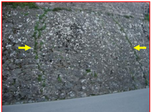
Centro abitato – Dissesto 016I-5GM-166. Muri fratturati lungo via Cavour - Tornello
