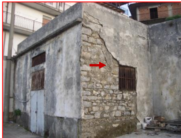
Centro abitato – Dissesto 016I-5GM-201. Locali serbatoio comunale
