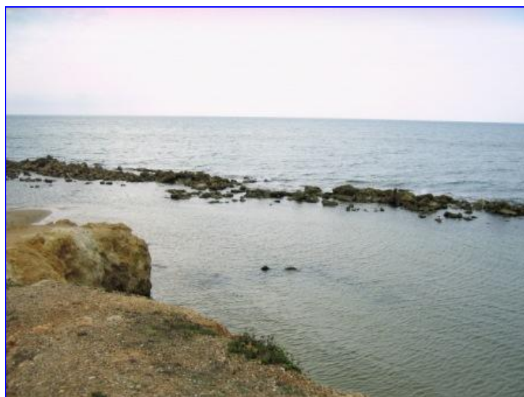
Foto 2.4 – Barriera emersa nella spiaggia a sud-est del porto di Scoglitti (Vittoria)
