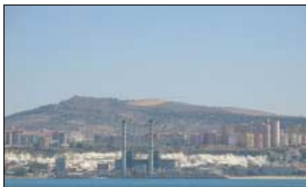
FOTO 2.7 - CENTRALE TERMoeLETTRICA (PORTO EMPEDOCLE)
