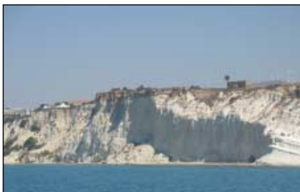
FOTO 2.5 - FRANA IN LOCALITÀ SCALA DEI TURCHI (REALMONTE)
